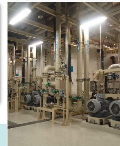
水系統轉動設備VFD節能
