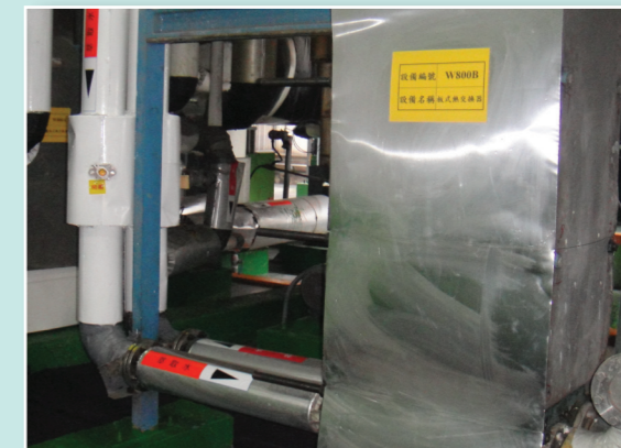
MVR入料板式熱交換器
