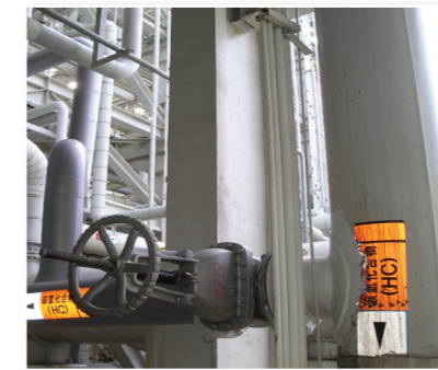
新增配管到煉油廠
