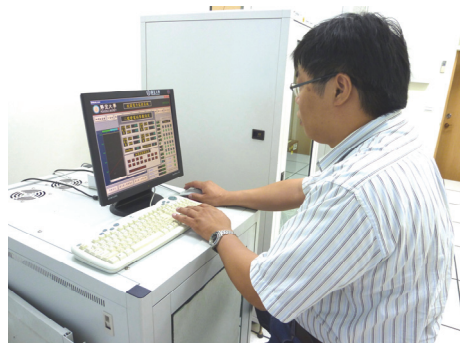
校園電監控與節能管系統設備
