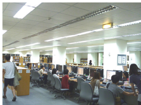
靜宜大學節能 T5 燈具設備
