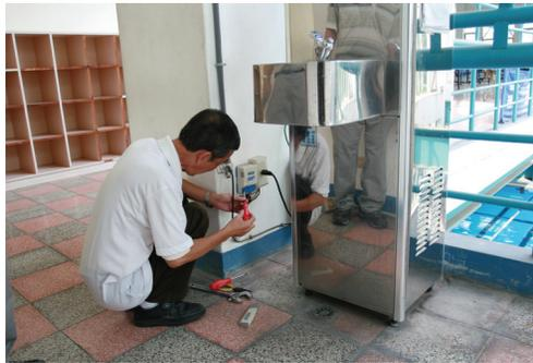
裝置定時器飲水機及電器類幾十項使用定時器相片
