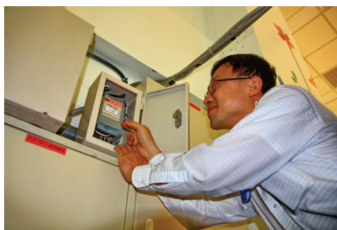
↑萊爾富在門市裝設數位電錶監控用電，在電力異常時能立即啟動維修系統，減少設備故障造成能源的浪費。
