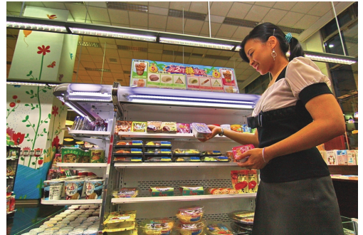
冰箱設備以 LED 照明
