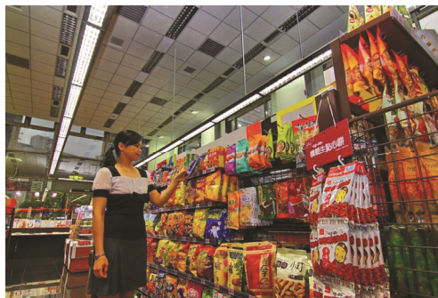
↑萊爾富賣場裝設 LED 燈具，並將燈距從 120cm 加寬至 180cm，減少燈具數量安裝所需的費用，也適度減少用電。
