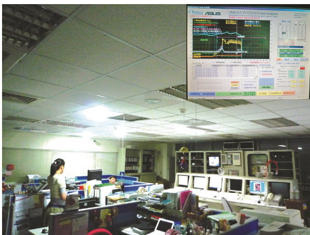
華碩辦公室照明採多迴路設計，增加使用彈性，降低無效照明用電。華碩建置的能源管理系統，即時統計分析各廠區空調及電力耗用狀況（右上）。
