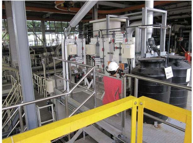
旺宏電子公司力行廠為 8 吋廠，該廠推動製程回收水改善計畫，將運轉多年的 8 吋廠達到 12 吋新廠之回收標準，製程回收水之回收效率已達 85%。
