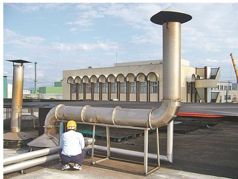
統一中壢總廠利用熱水管原理，將烤爐廢熱做有效的回收，回收的熱水再做為清洗烤盤之用，明顯降低蒸氣費用。
