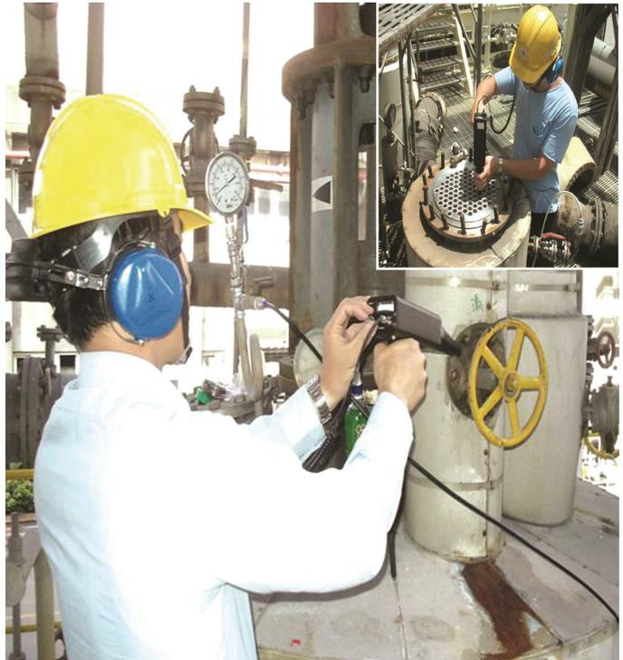
提升能源使用效率也是節能的重要工作，南亞塑膠公司樹林一廠不定期對回收管路與熱交換器進行洩漏檢測與偵測，將能源做最有效的利用，也確保能源損耗降至最低。
