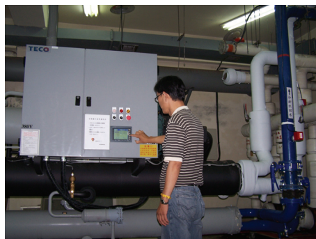
高效能冰水主機操作
