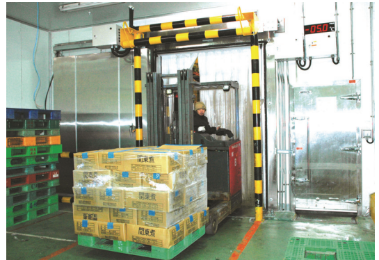
統昶行銷公司將冷凍倉庫前增設-5°C緩衝室，減少熱氣進入冷凍庫，降低熱負荷，也同時減少熱濕空氣進入冷凍庫，有效減少結霜，提高冷凍機效能。
