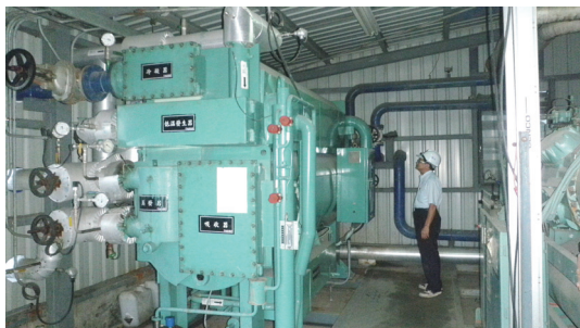
增設 吸收式冷凍機
