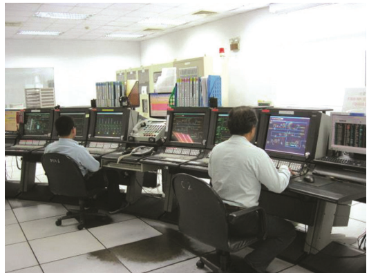
台灣化纖製程 4.5K 低壓外送系統，自產蒸汽量每小時 150 公噸，透過監控方式管理，讓能源使用效率由 19% 提昇為 42%。
