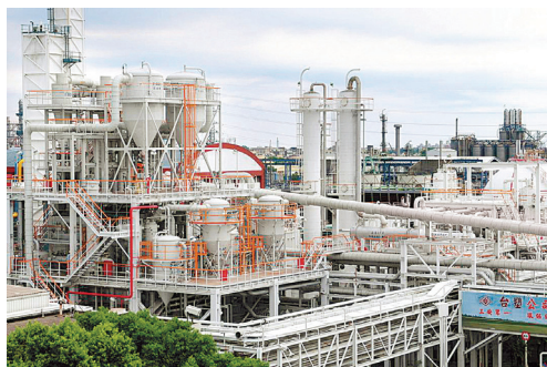
台塑林園聚丙烯廠進行庚烷蒸餾塔製程及操作改善，一年可節省蒸汽 34,400 公噸，降低 CO 2 排放 9,873 公噸。
