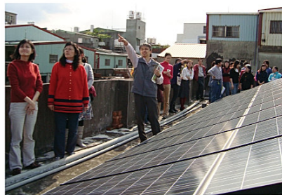
設置太陽能光電板供師生參觀
