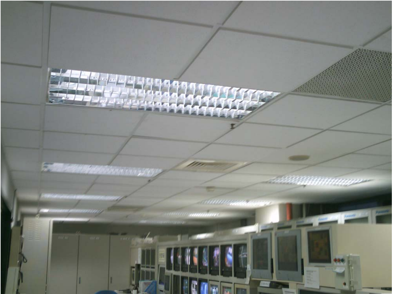
圖1、中控室照明更改為T5三波長高效率省電燈具圖
