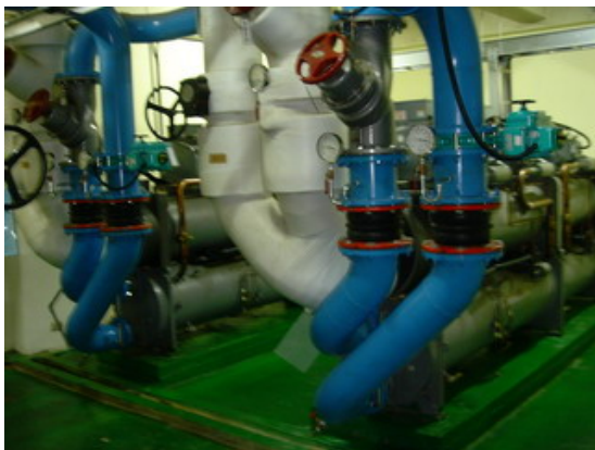
恩典樓空調主機
