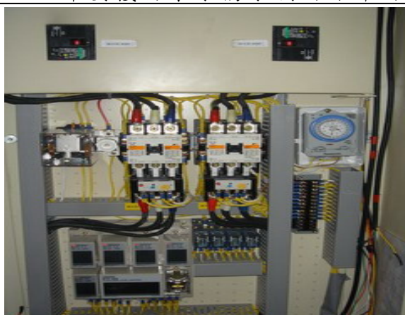
控制電路加裝定時器
