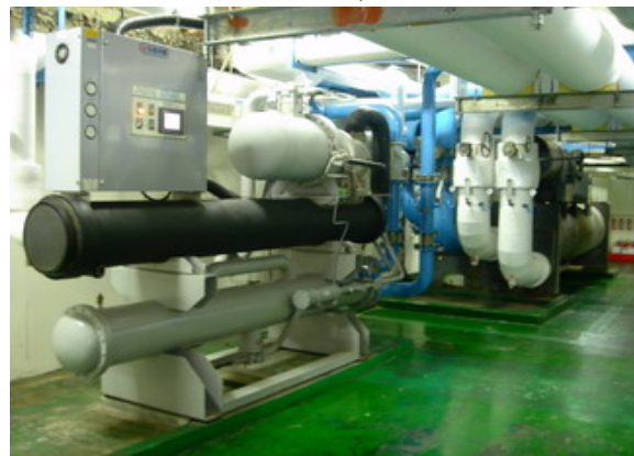
喜樂樓空調主機
