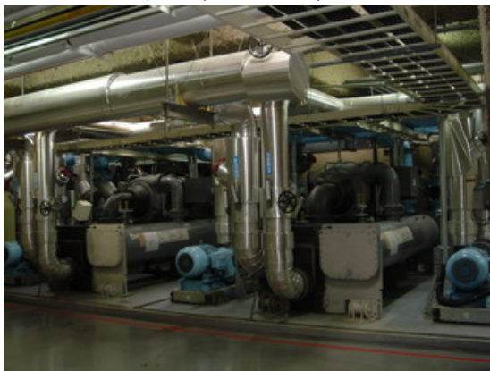
平安樓空調主機
