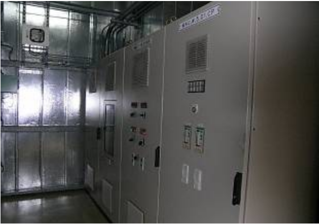
4. MAU空調箱溫/溼度控制器照片
