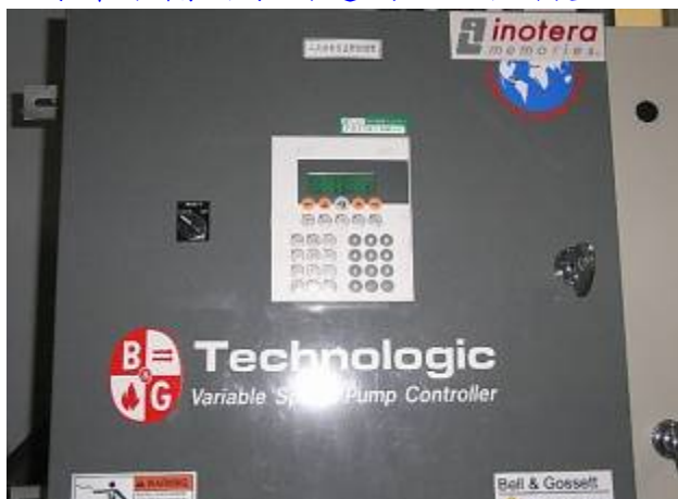
3. 冷凍水輸出泵浦遠端壓差控制盤
