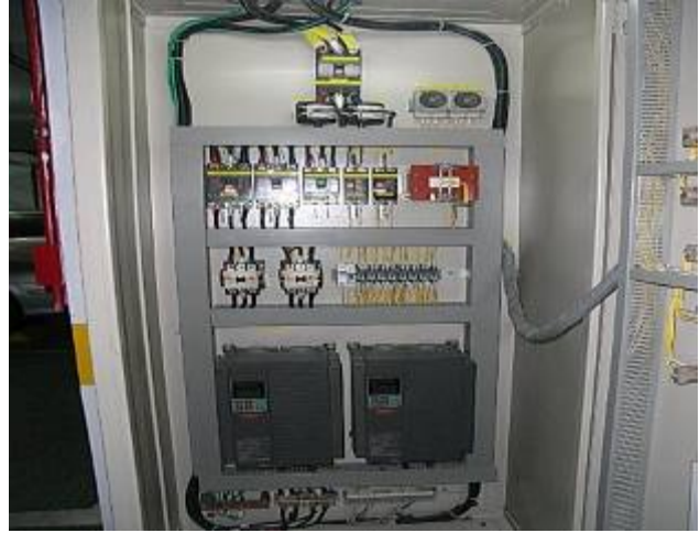
2.地下停車場排氣風車電盤照片(兩組變頻器/兩組計時啟停控制器)
