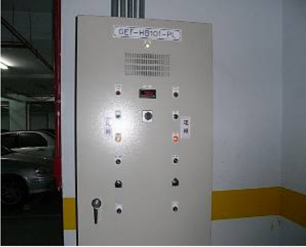
2.地下停車場排氣風車電盤照片(兩組變頻器/兩組計時啟停控制器)
