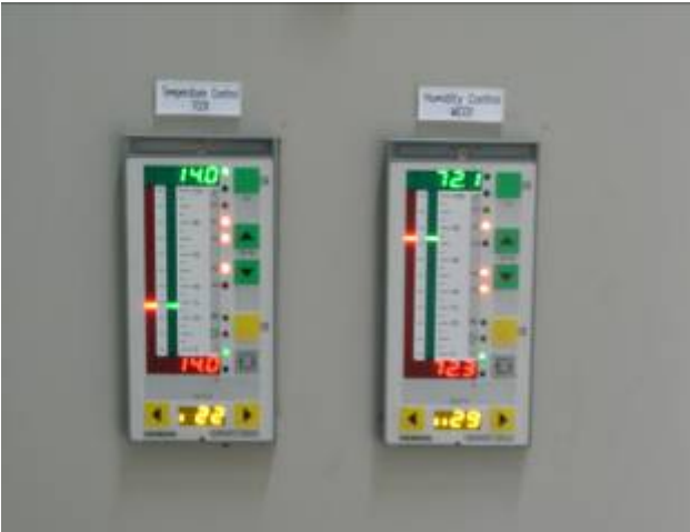
4. MAU空調箱溫/溼度控制器照片
