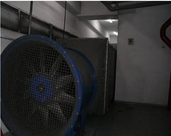
3. 地下停車場排氣風車照片
