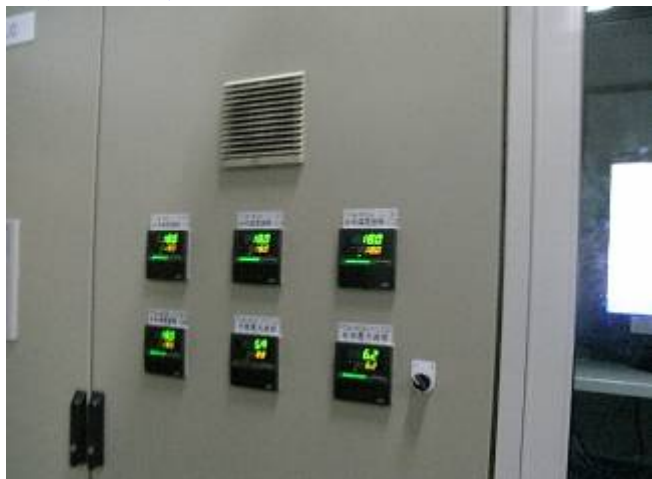
3. 製程冷卻水供應輸出壓力控制器
