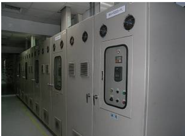
3. 冷凍水輸出泵浦遠端壓差控制盤
