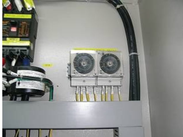
2.地下停車場排氣風車電盤照片(兩組變頻器/兩組計時啟停控制器)
