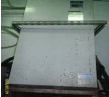
改善前：原廠隨機之冰水機
