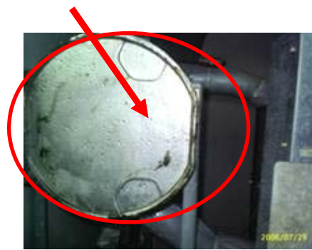
改善前：冰水機內部損壞之冷熱交換器
