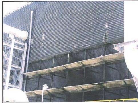
冷卻水塔增設檔水板
