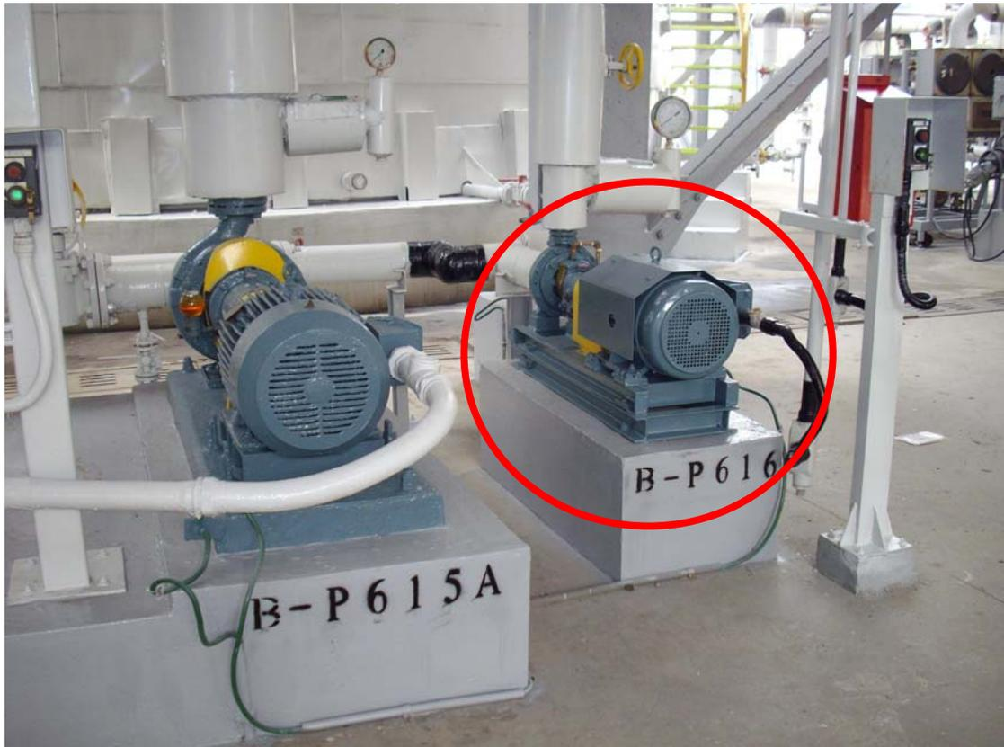
配合粗EG槽(T-615)改採少量回收之需求，輸送量由 $108\text{M}^3/\text{Hr}$  (原有P-615)降低為 $10\text{M}^3/\text{Hr}$  (新設P-616)，以節省電力。
