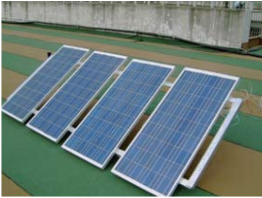
太陽能發電系統
