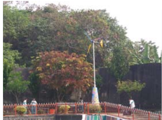
風力發電機組
