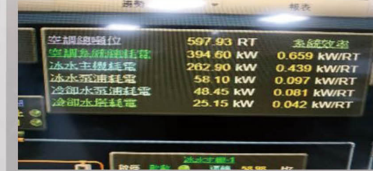
冰水系統運轉效率即時管理
