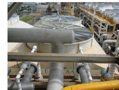
重油脫硫單元空冷器前注水
