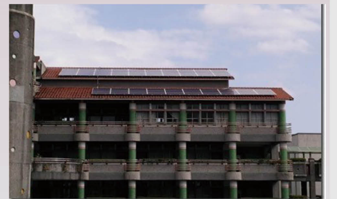
綠建築增設太陽能設施
