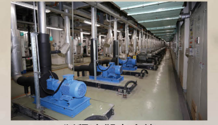
製程冷卻水系統
