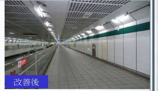
車站區照明設施更新
