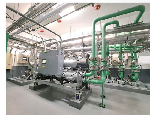
導入人工智慧變頻空調與能源管理 -B1F 主機房 - 打造全國第一台採用全人工智慧變頻控制技術之磁浮離心式及螺旋式空調主機
