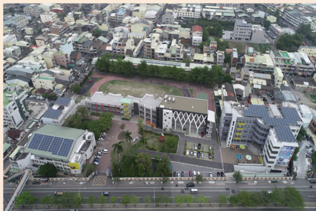
屋頂太陽能光電系統
