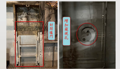
封閉加熱爐檢查門，增設窺視孔
