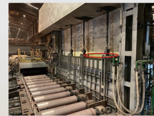
改造出料爐門，提升密封性 減少熱散失
