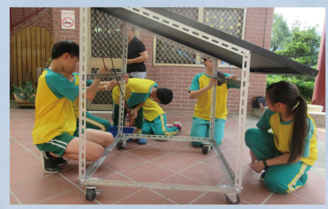
動手組裝太陽能板裝置
