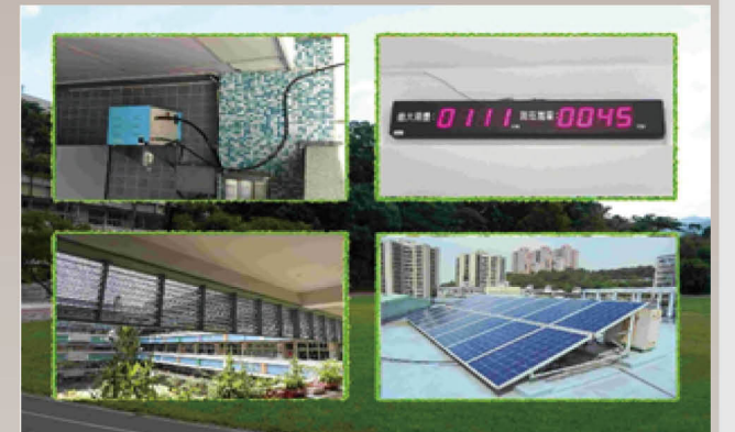
智慧校園節電措施 - 降溫水霧、智慧節電、節能遮陽板、太陽能發電設施
