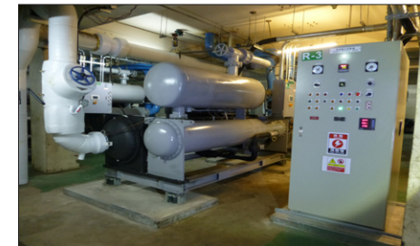
更換冰水主機
