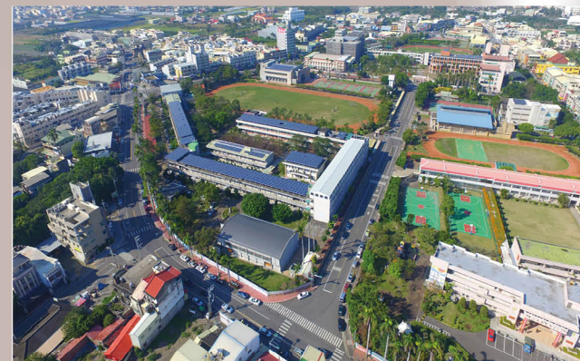
屋頂太陽能光電系統
