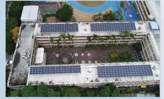
屋頂設置太陽能板
