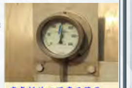
廢氣排放口溫度已降至 149°C，完全符合法規，低於 160°C 的規定。
