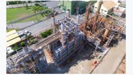
更新後裂解爐
