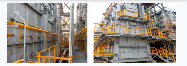
裂解爐更換 32 盞 100W 水銀燈為 40W LED 燈
