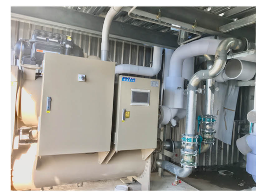
磁浮水冷離心式冰水機組
