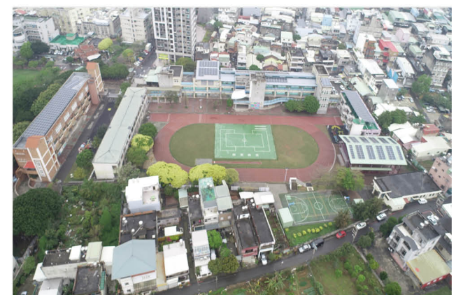
屋頂架設太陽能板
