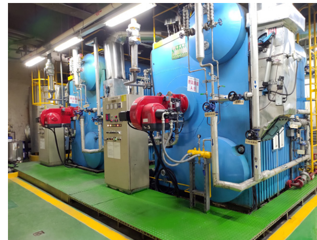
鍋爐燃燒機汰換
