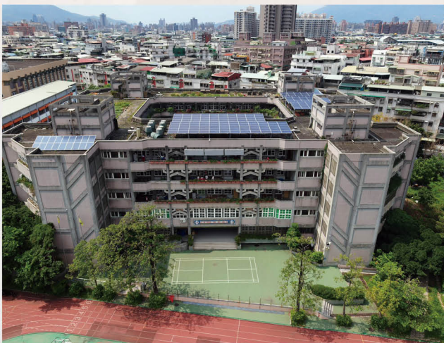
設置屋頂太陽能光電系統 (52kw)
