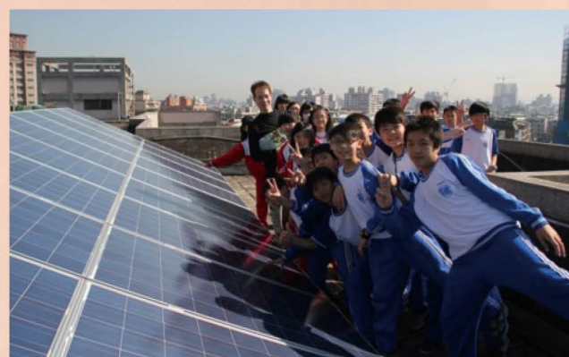
屋頂太陽能光電系統導覽課程
