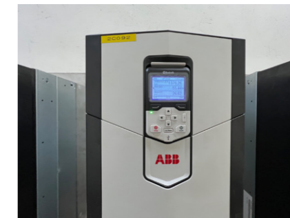
1&2K 冷卻機風車改變頻控制 (低壓)
