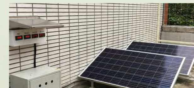
架設太陽能板
