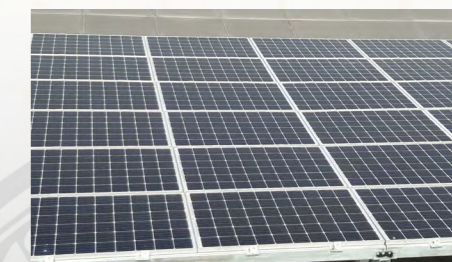
太陽能光電設備
