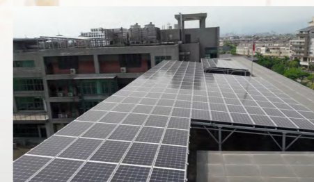
頂樓裝設屋頂型太陽光電設備
