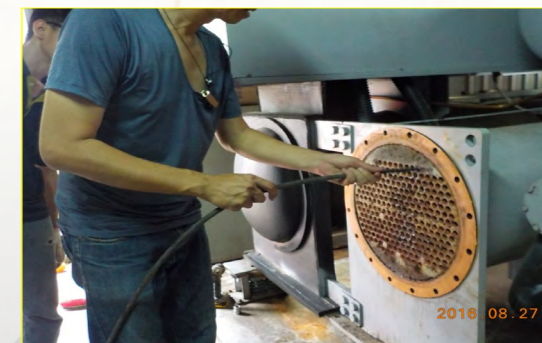
醫療大樓空調系統改善冷凝器傳熱
