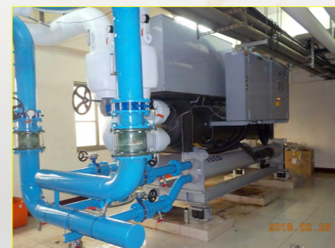
醫療大樓採用高效率冰水主機
