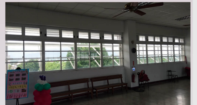
西曬教室裝設外遮陽設施
