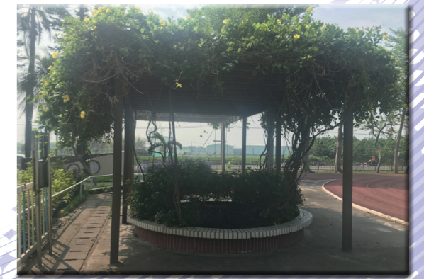
舊禮堂廢木材再生運用巧思設計為花棚架，以及兵器架。花棚架立於操場旁邊，軟枝黃蟬攀附其上，多了乘涼的空間。
