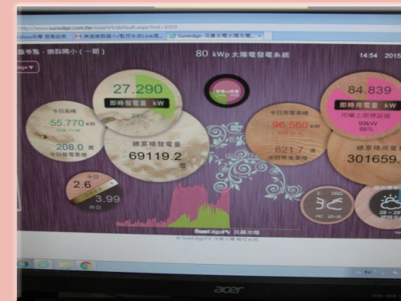
智慧發電與用電監控系統
