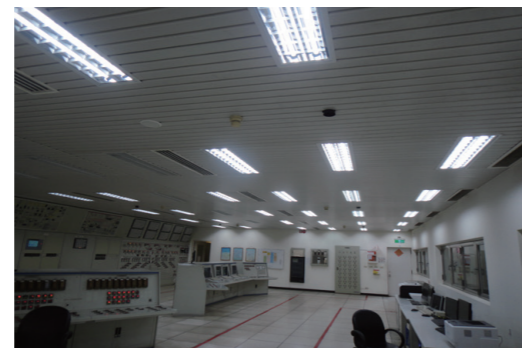
八里焚化廠照明改善
