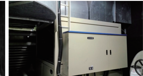
1 號熱泵主機取冷供客房用，取熱供洗澡用
