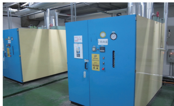
煙管式鍋爐汰換成高效能貫流式鍋爐
